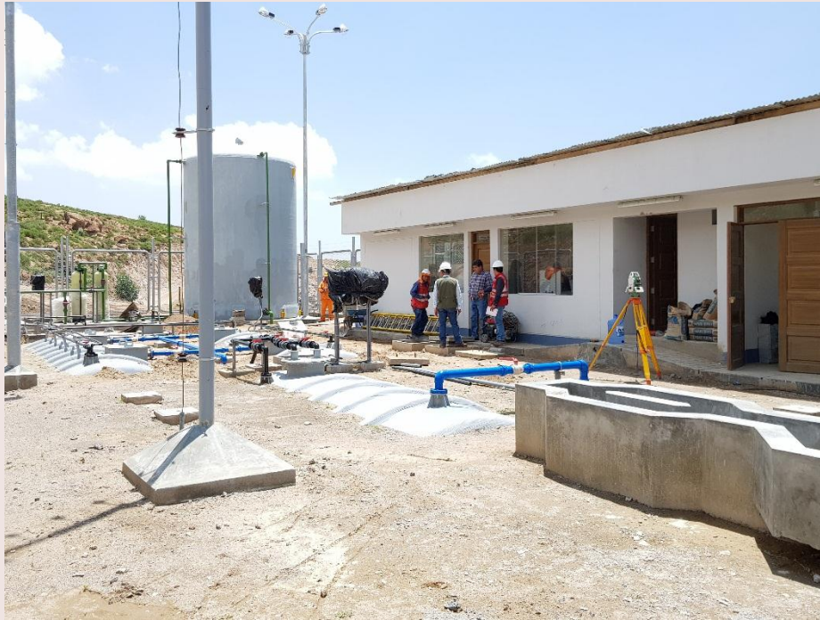
Obras de instalaciones eléctricas, para el adecuado tratamiento de Aguas Residuales de Quichinihuaya
